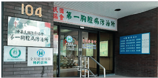
一、門戶形象：從傳統診所到現代醫療中心 左（舊）：傳統第一胸腔病防治所門面（裝修前） 右（新）：北醫附醫委託經營之現代化外觀（裝修後） 設計重點：強調品牌識別整合與採光通透感。
